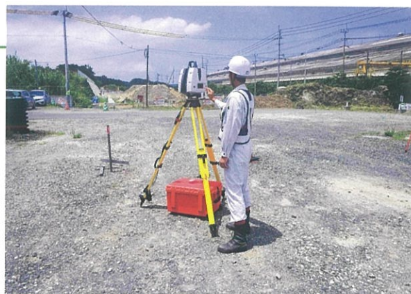
【現場での測量作業風景①】
