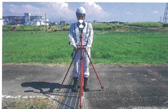
【現場での測量作業風景②】
