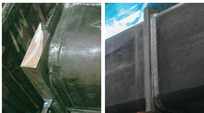
手溶接(写真左)と自動溶接(写真右)では仕上がりも異なる
