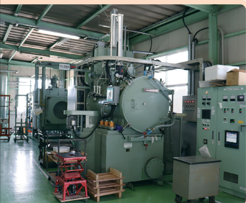
平成27年度ものづくり補助事業で導入した多機能真空熱処理装置
