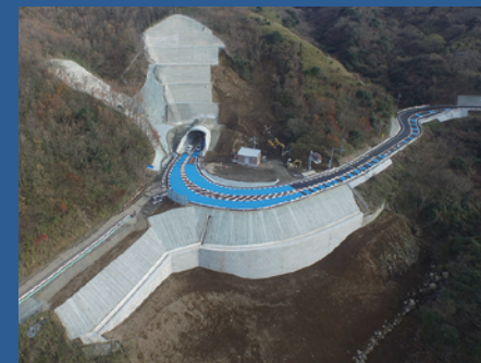
（2016年熊本地震で被災した俵山トンネルルートの復旧工事にも参入）
