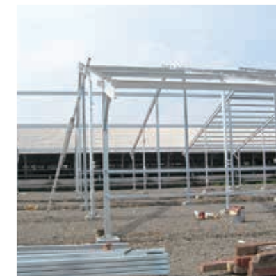
牛舎の組立状況
