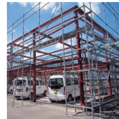
ビルの組立状況
