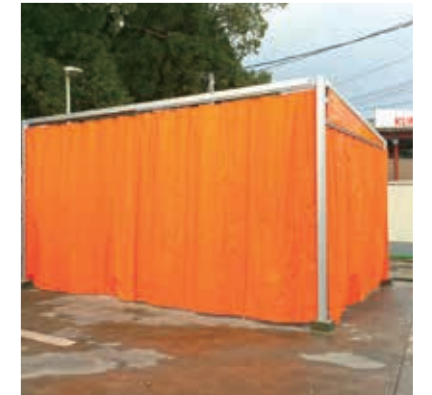
開閉テント車庫
