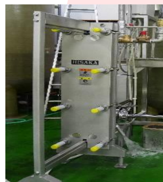
プレート式熱交換器
