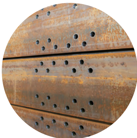
従来できなかったH形鋼や角形鋼管の孔開加工を内製化
