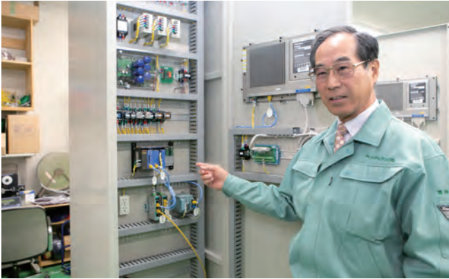
水力発電所で自動制御・遠隔監視技術が活用されている
