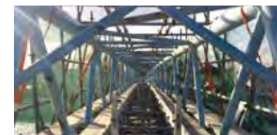
沿岸部での水門の据え付け工事など新しい仕事が広がった
