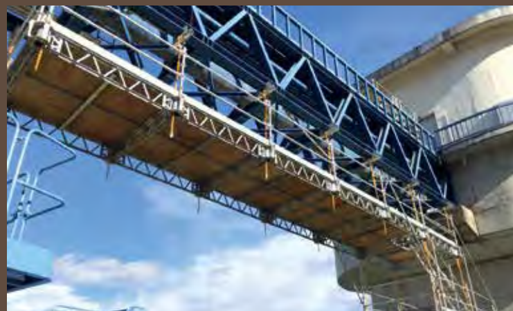
足場が宙吊りになる現場でも、床が先行してできるので安全に作業が進む
