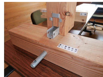
接合金物をスリットに取り付けた例
