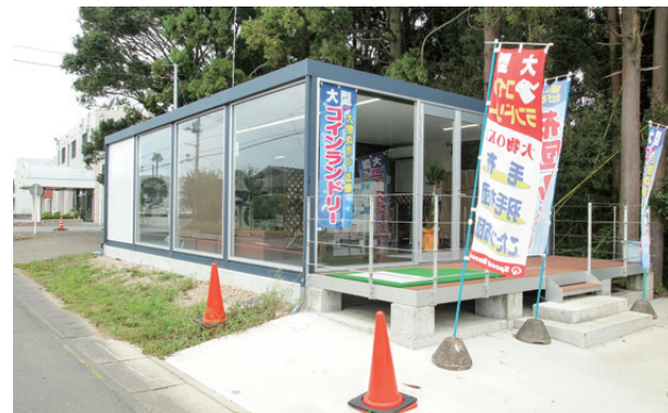
コインランドリーのガラス張りで開放的な空間が、利用者に好評である
