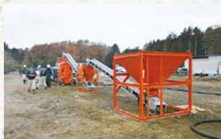
工事現場に設置された吹付プラント。手前からサンドホッパー、計量器、コンクリート(モルタル)吹付機
