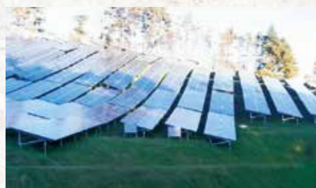
施工完了後に種が発芽して緑化が進んだ発電施設内
