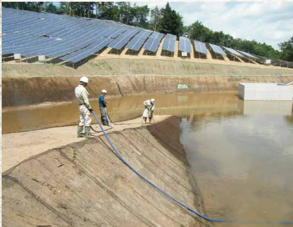
建設中の太陽光発電施設での吹付工事(種子散布)の様子
