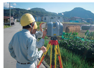
3Dレーザースキャナーを使って測量をする様子
