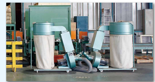
④釘打機の後ろに配置された自動コーナー加工機 →コーナー加工（R加工）が必要な商品は、釘打工程後に自動でR加工される
