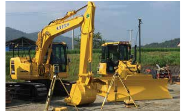
【ICT建機(左)MGバックホウ、(中)GNSS基地局・移動局、(右)MCブルドーザー】
