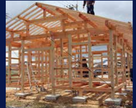
【伝統構法による施工】
