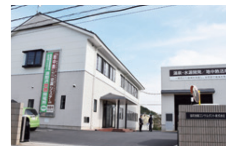
協和地建コンサルタント本社
