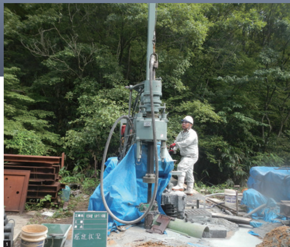
1 ダウンザホールハンマーを使った試掘
