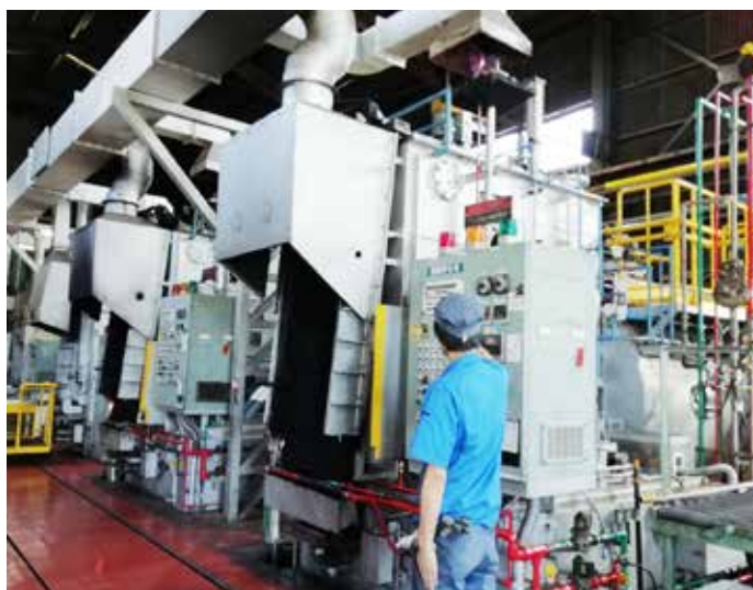
工場内設備の作業
