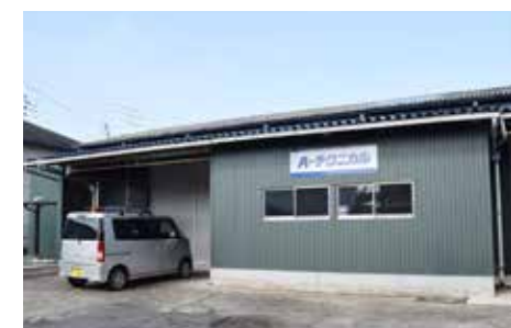
A-テクニカルの工場
