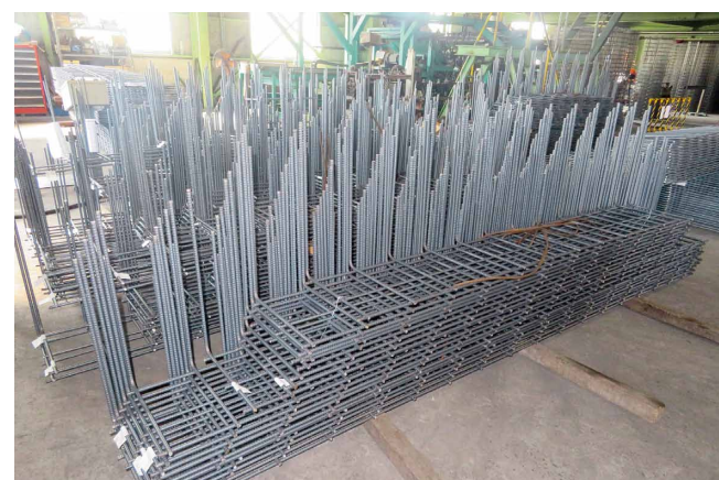
鉄筋金網のセット。立ち上がり部がきれいに曲げられている
