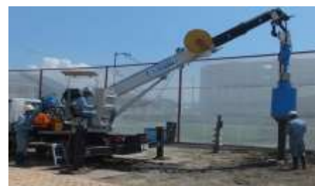
「ハイスピード工法」施工風景
