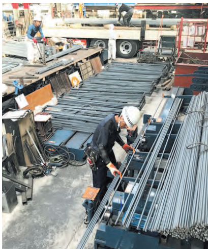
自動曲げ機で加工
