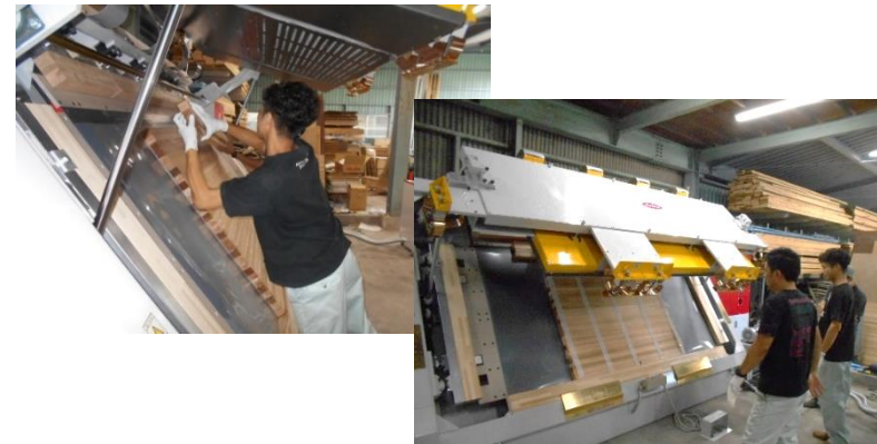
高周波巾はぎ接着機による作業風景
