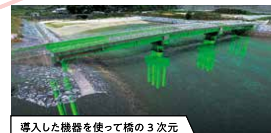
導入した機器を使って橋の3次元モデリング化が可能になった
