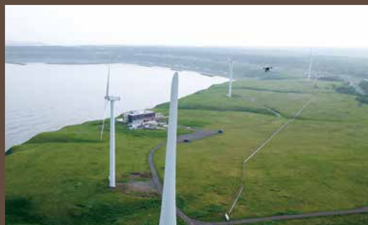
風力発電施設の点検は、高所作業で危険が伴う
