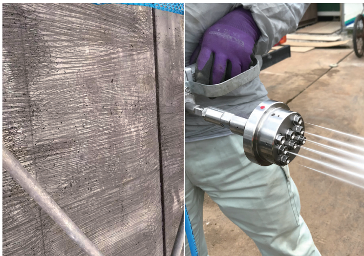
刷毛引きしたコンクリート面
