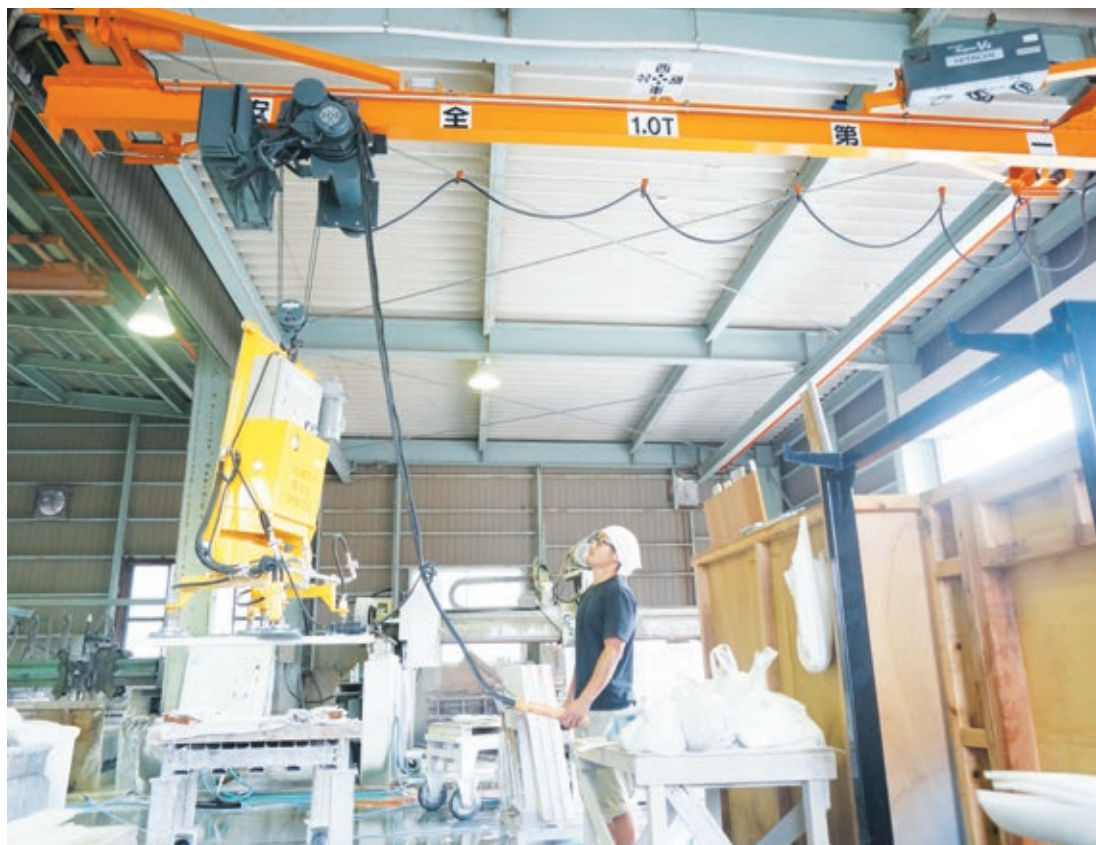
今回導入した反転式バキュームリフトと天井クレーン
