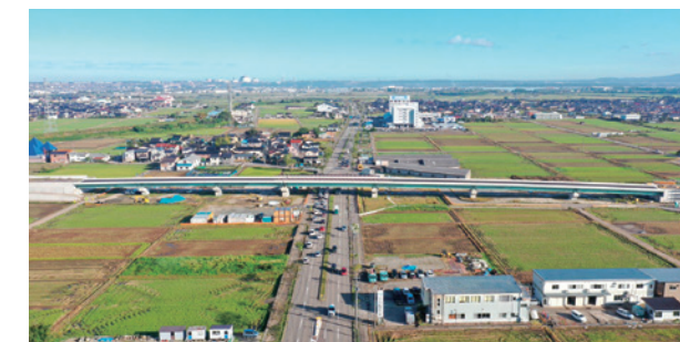
金沢外環状道路 大浦高架橋（完成）
