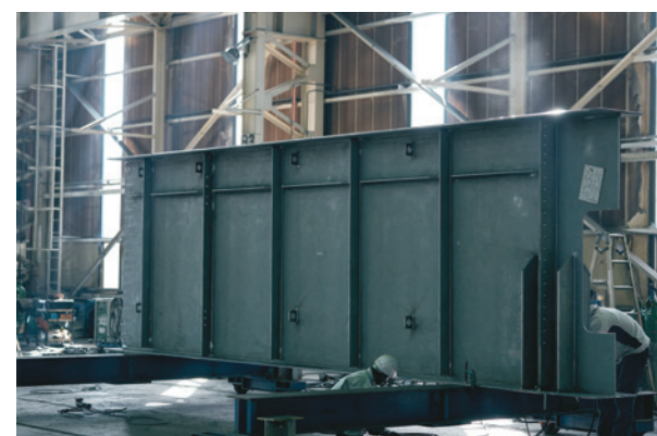
工場で製作中の橋桁
