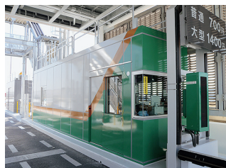
高速道路料金所ブース
