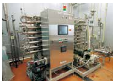
加熱・冷却型酵素失活装置
