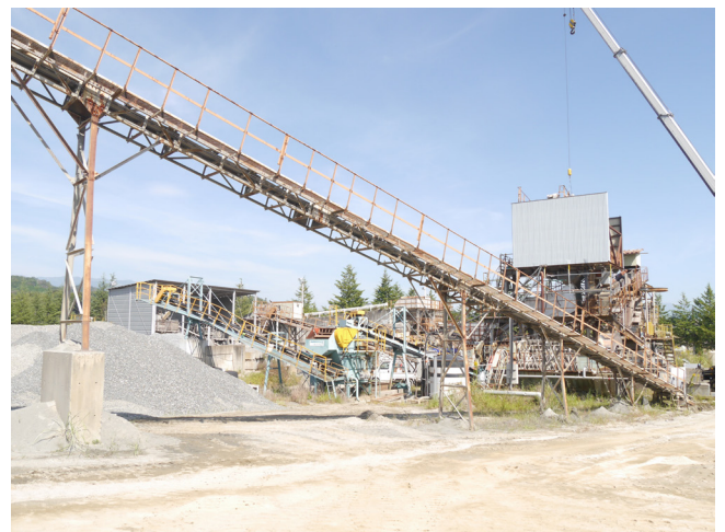
砂利製造プラント
