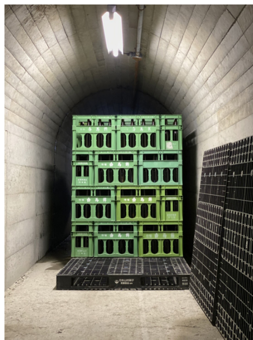
トンネル貯蔵（大町市七倉ダム）
