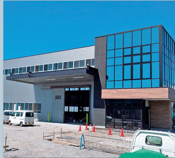
令和2年4月竣工の新工場
