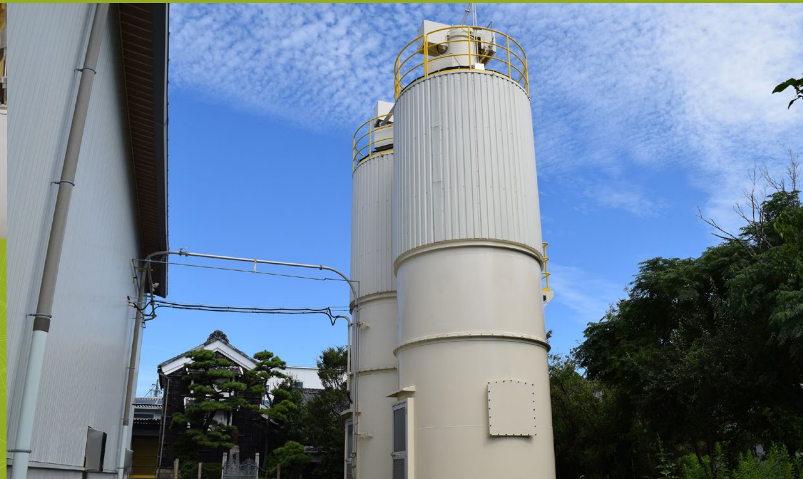
■ 収容能力15トンのサイロ(手前が薄力粉用、奥が強力粉用)
