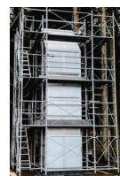
長万部の水柱に防音パネルを取り付け
