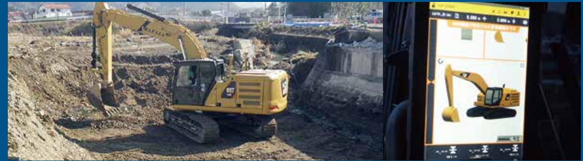
【3D建機を使った現場作業】
