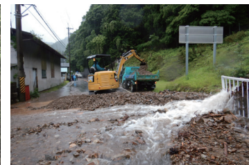
土砂撤去工事
