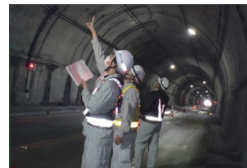
トンネル整備工事
