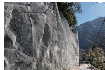
法面对策工事
