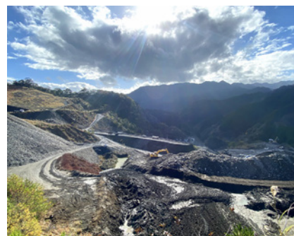
良質の硬質砂岩が採取される宇藤木工場
