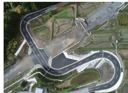
ICT技術を活用して完工した道路工事
