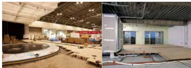
施工事例（左：東京モーターショー、右：マンション）
