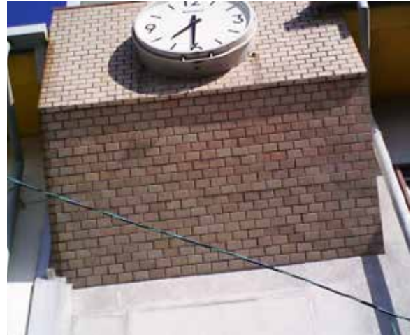
外壁タイルの浮きや剥離の調査事例（調査対象）
