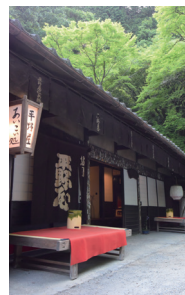
古民家耐震改修
