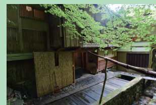
古民家耐震改修
