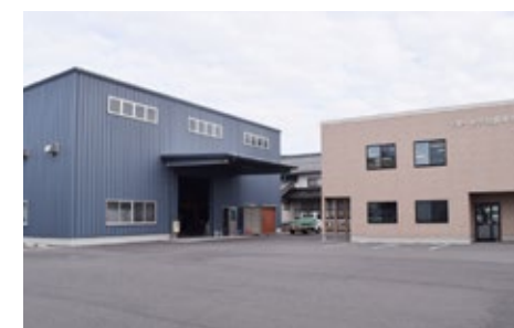
松栄設備の全景
