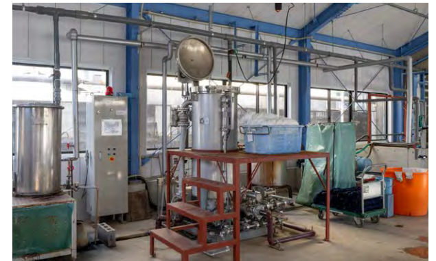
▲導入した高温高圧汎用染色機
