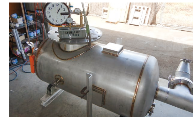
▲1箇所に3回の溶接、熟練工が1時間を要していた
