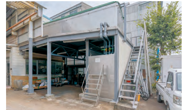
▲上がプール、下が遮水扉付き水槽、実験の様子は屋上から見学できる
