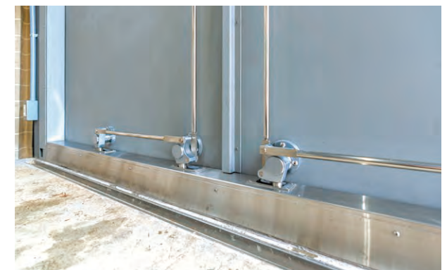
▲当社独自開発のセギリプレート方式により、遮水ゼロを実現
