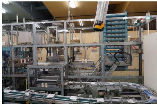
自動でコンテナを積み上げる
