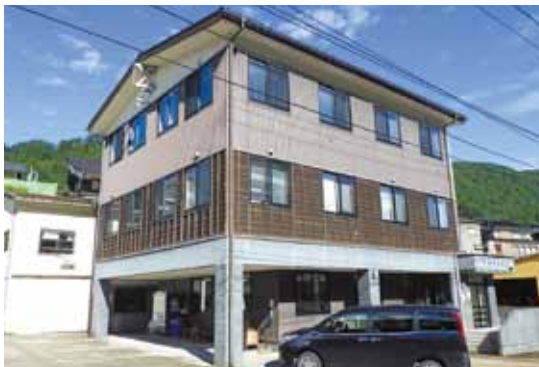
山間地工事の拠点となる本社工舎
