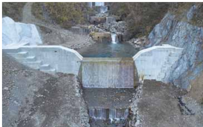
ICT施工によって完成した現場
