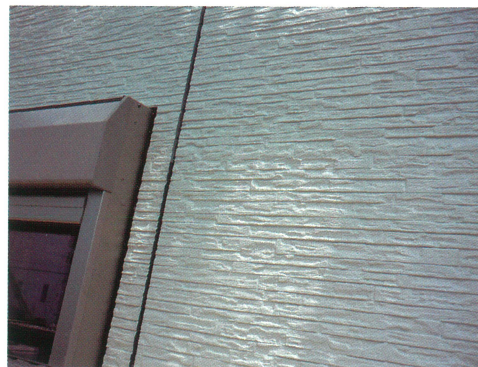
施工されたサイディング
